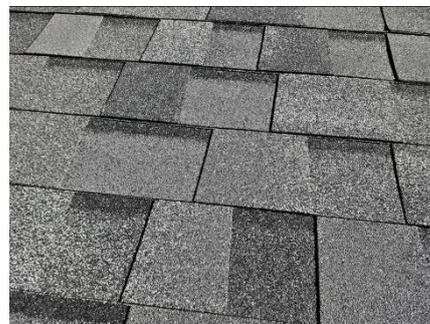
Армирующей основой черепицы является стеклохолст, покрытый резино-битумом (SBS), обеспечивающим эластичность и прочность продукции. На верхней стороне черепицы нанесена посыпка, защищающая от внешних погодных воздействий. На нижней стороне – клеевые полосы.
